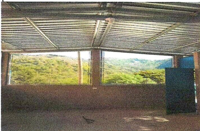
Foto 3: Finalización de instalación de techo y energía eléctrica.
