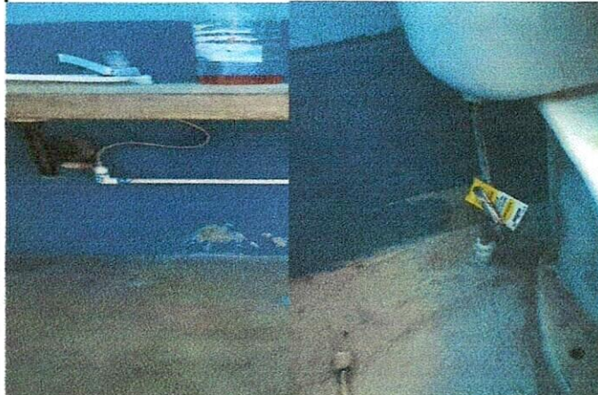
Foto 4: Finalización de nueva tubería para los baños de niñas y niños.
